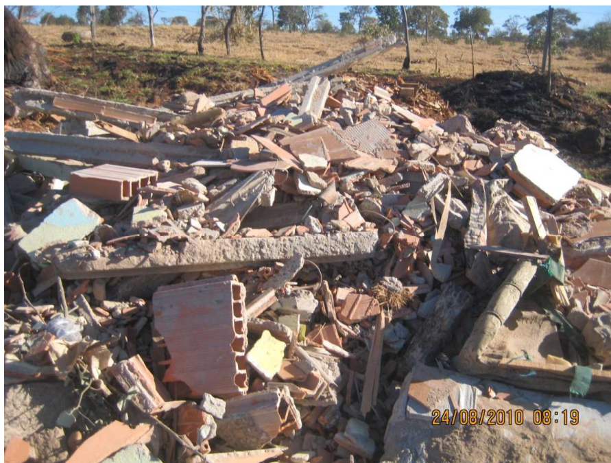
Figura 11 - Ponto crítico de disposição inadequada de resíduos da construção
