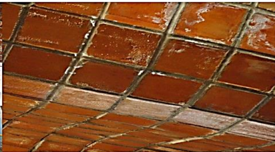
Infiltração e risco de desprendimento das placas de cerâmica da cobertura
