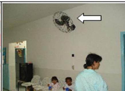
Ventiladores sem 2º ponto de fixação na parede
