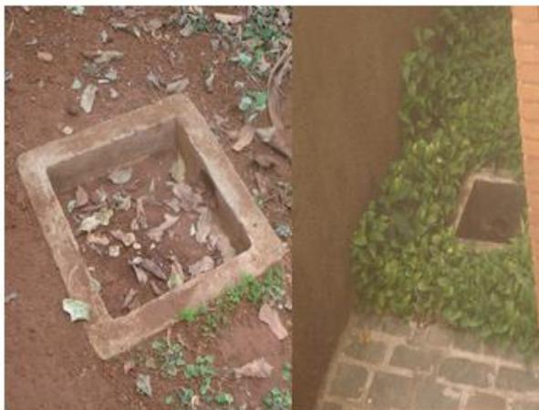
Caixas de água pluvial sem tampa.
