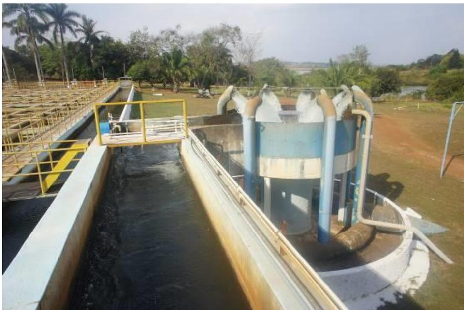
**Foto 04** – Vista geral da chegada da água bruta na ETA Sucupira e aplicação de suspensão de cal da forma de pré-alcalinização
