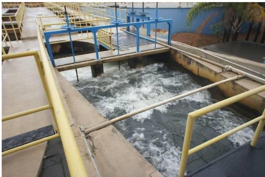
**Foto 11** – Vista geral da estrutura divisora de vazões implantada na ETA Bom Jardim
