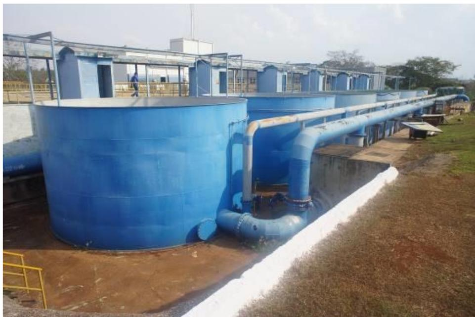
**Foto 05** – Vista geral das unidades de filtração de seção circular implantadas na ETA Sucupira
