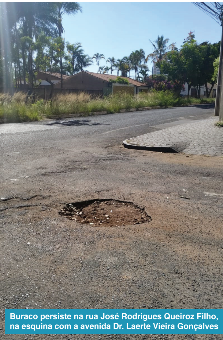
Cratera na rua Sebastiana Arantes Fonseca é alvo de reclamação de moradora da via
